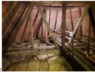
Gewölbe von oben unterm Dach !
